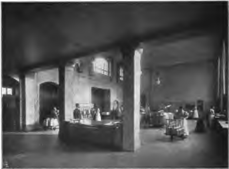
Abb. 140. Kochküche im Krankenhaus Westend.
